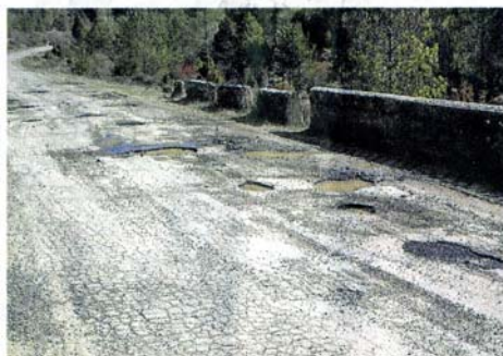
El puente de Izarbe, cerca de Anzánigo, está lleno de baches. C. SEGARAL
