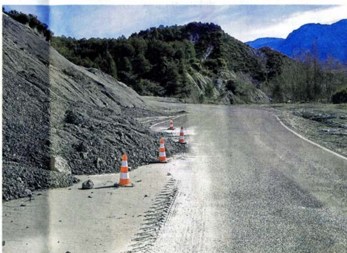
Cuatro conos señalizan un desprendimiento junto al pantano y el pueblo de La Peña. COORDINADORA SEGARAL
